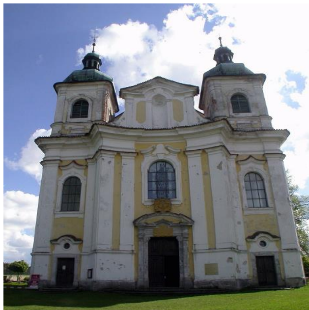
Stav před obnovou
