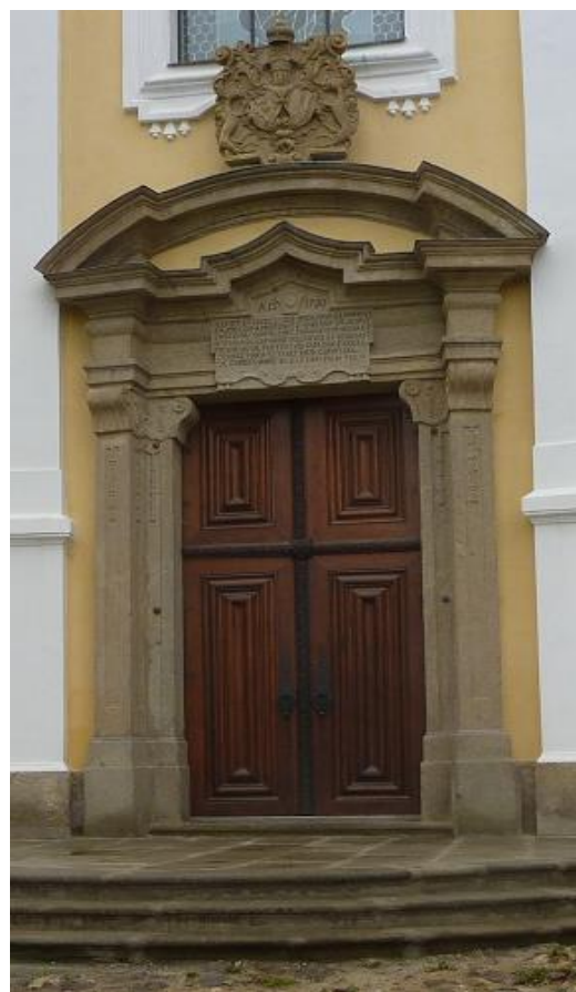
Portál a schodiště po obnově
