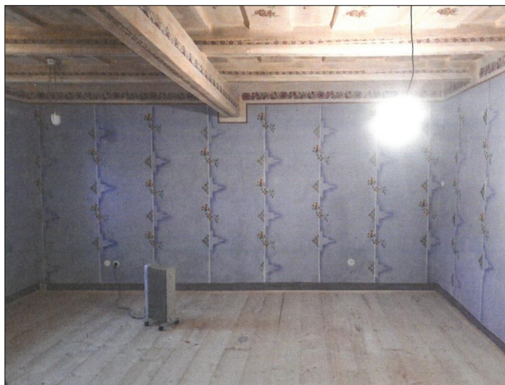
Stav interiéru po obnově
