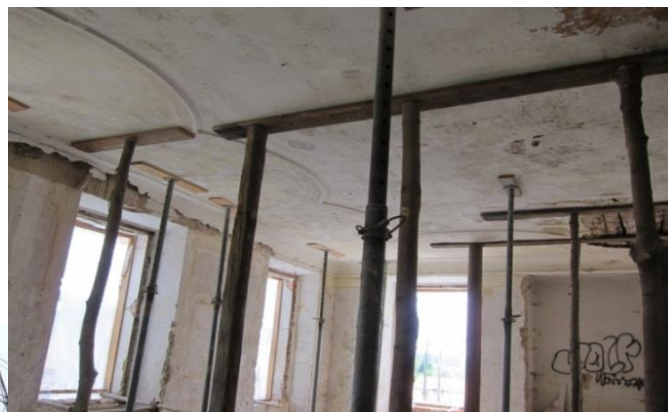
Stav památky před obnovou
