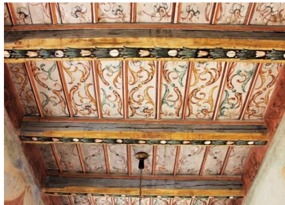
Restaurovaný strop kaple
