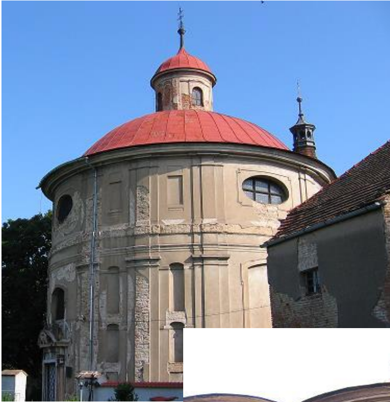
Stav objektu před opravou
