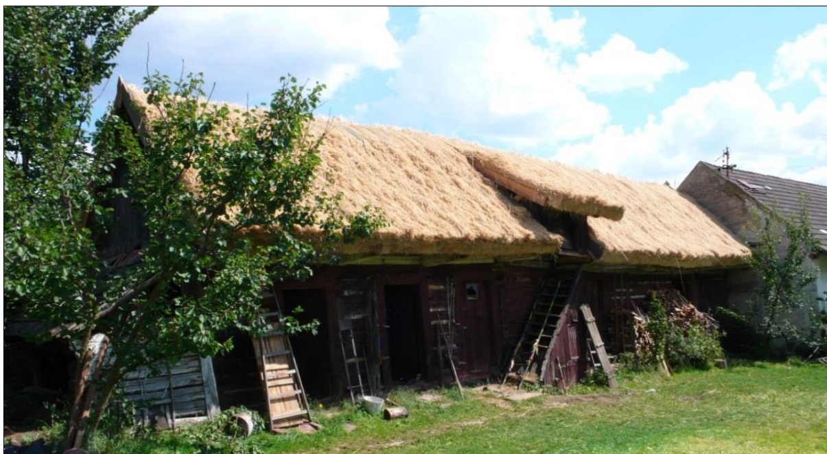
Stav objektu po obnově
