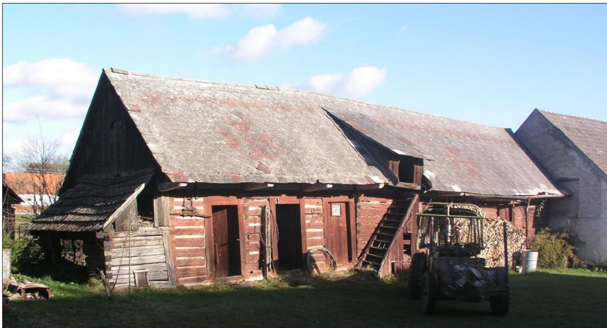
Stav objektu před obnovou
