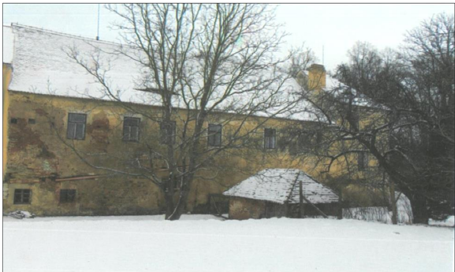
Stav objektu před obnovou
