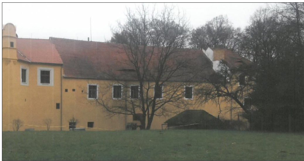
Stav objektu po obnově
