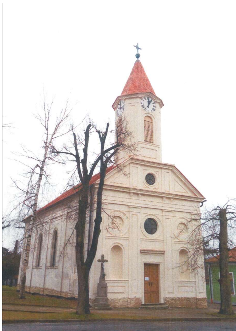
Stav objektu po obnově
