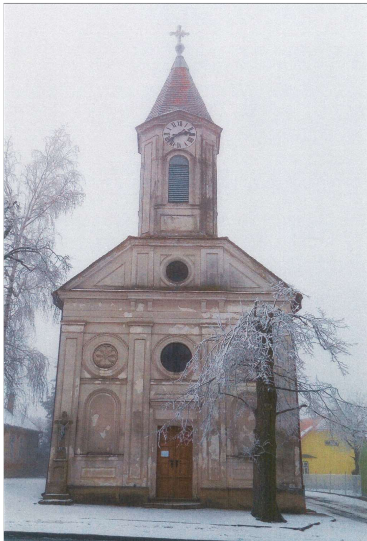
Stav objektu před obnovou
