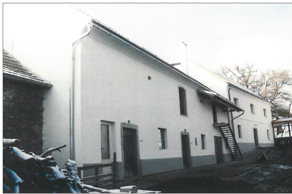
Stav objektu po obnově
